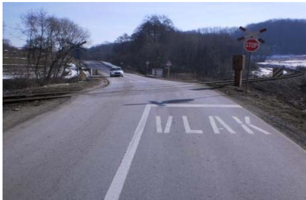
Slika br. 14 - Km 24+860 željezničko cestovni prijelaz
