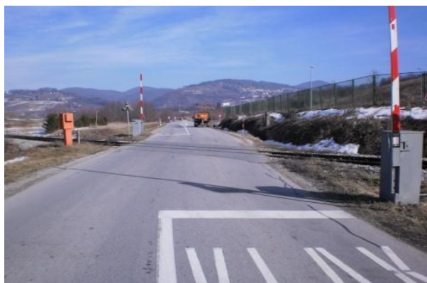
Slika br. 13 - Km 23+795 željezničko cestovni prijelaz
