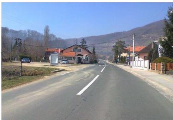
Slika br. 7 - Kraj dionice Mađarevo, km 30+158, iza raskrižja sa lokalnom cestom LC25134
