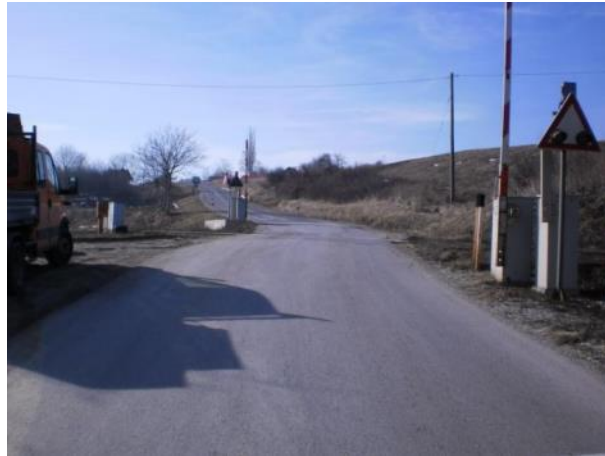
Slika br. 8 - Km 28+888 uspon i pružni prijelaz Mađarevo
