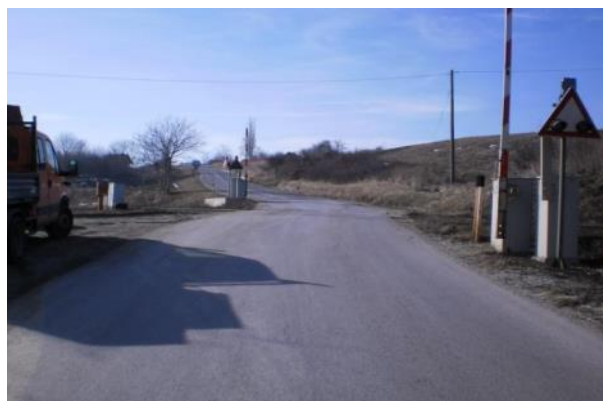
Slika br. 15 - Km 28+888 željezničko cestovni prijelaz
