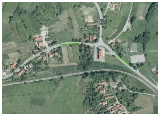
Slika br. 11 - Klizišta na km 22+826 do 22+999 i od km 23+108 do 23+187
